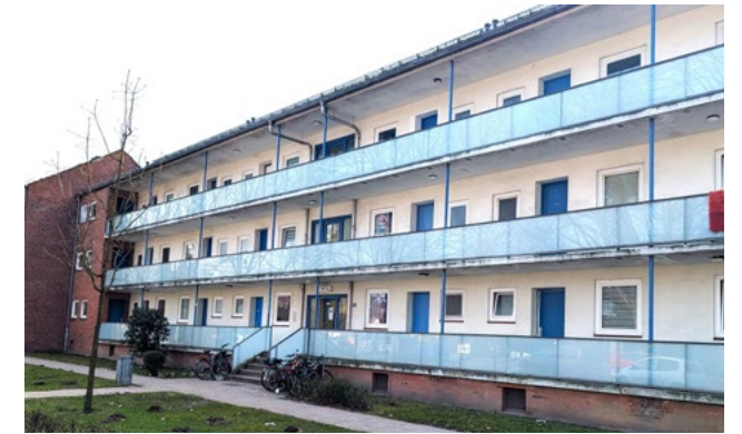
In die Jahre gekommen – das Quartier Elfsaal soll komplett erneuert werden.
