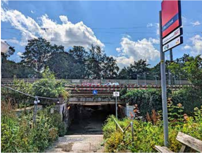
Der Fußgängertunnel in Wandsbek-Marienthal soll für ca. zwei Jahre gesperrt werden.
