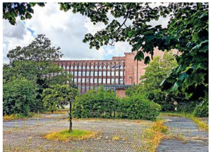
Das Telekomgebäude an der Walddörferstraße soll zentrale Erstaufnahmestelle für Asylsuchende werden.
