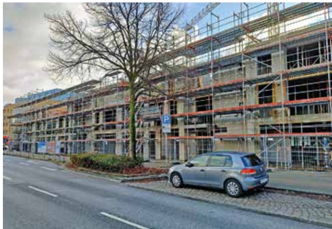
Neubau von Wohnungen in der Ahrensburger Straße.
