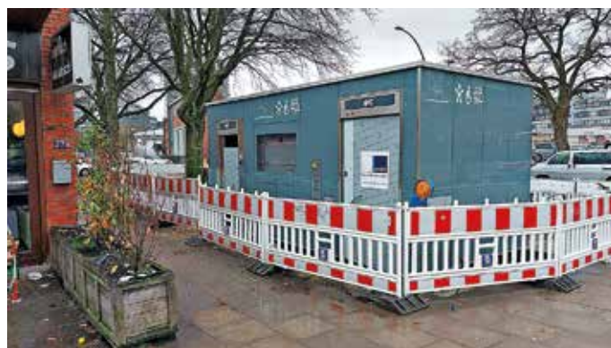
Noch im Bau, aber in den nächsten Tagen fertig: Das neue Toilettenhäuschen an der Wandsbeker Chaussee. Foto: Winfried Mangelsdorff
