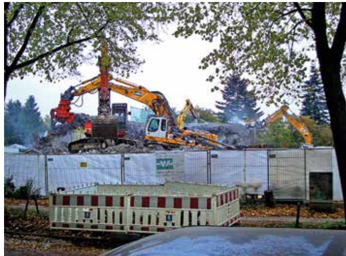
Abbruch des Bunkers 2009 in der Stephanstraße 133. Foto: Holger Schomaker
