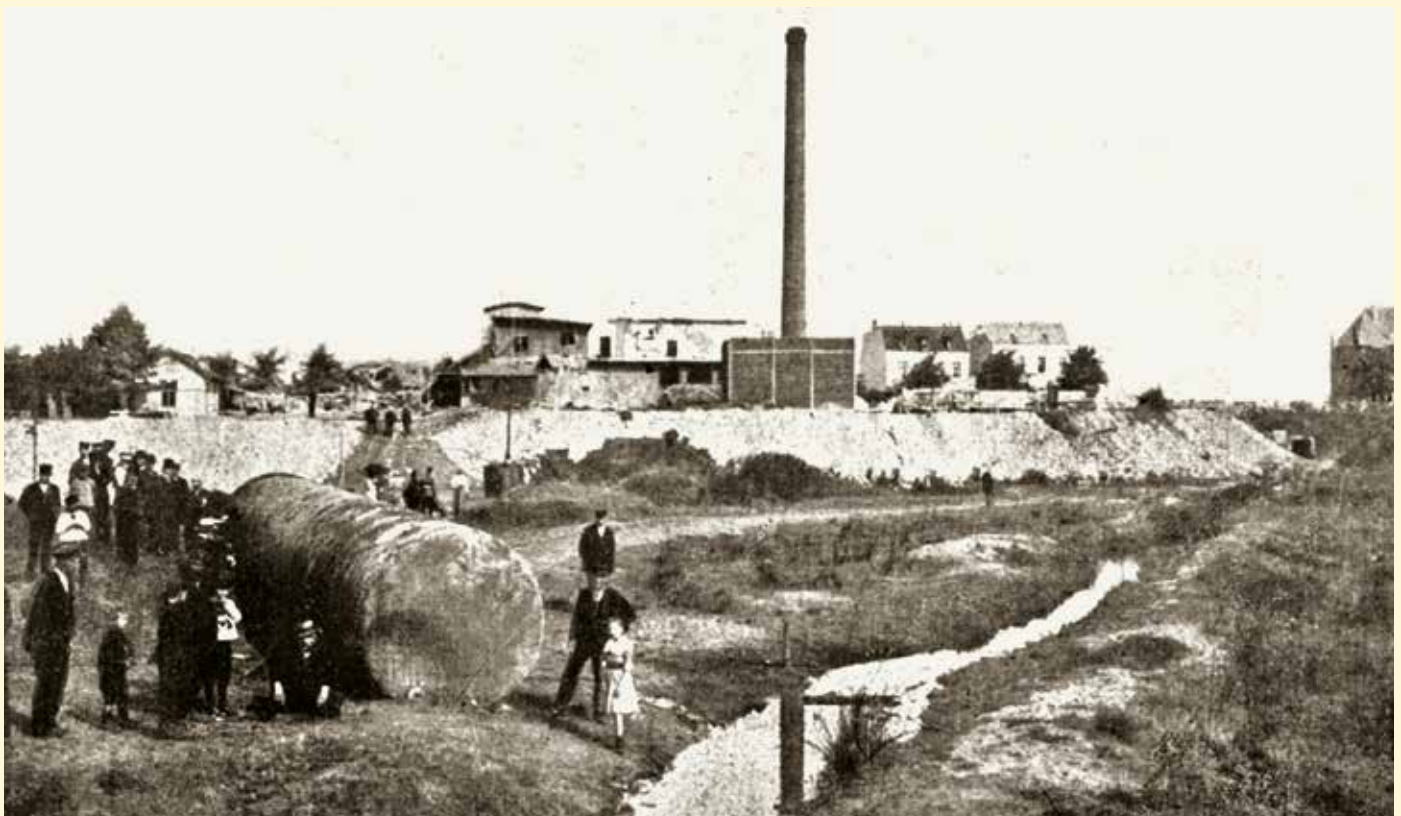
Am 3.8.1911 explodierte in dem Hinschenfelder Hartsteinwerk Wulfe ein Kessel und flog hinunter bis zur Wandse. Die Wucht der Explosion war so stark, dass auch das Fabrikgebäude wie ein Kartenhaus in sich zusammenfiel. Fotos: Archiv Heimatmuseum Wandsbek
