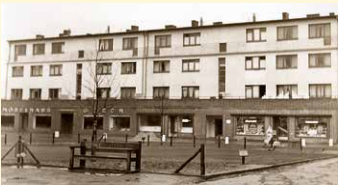
Wohngebäude mit den Hausnummern 12 und 16 und dem Möbelhaus Gösch 1952.
