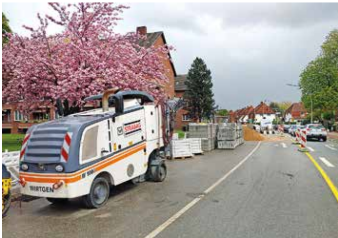
Es sieht nach einer Menge Arbeit in der Tilsiter Straße aus. Foto: Winfried Mangelsdorff
