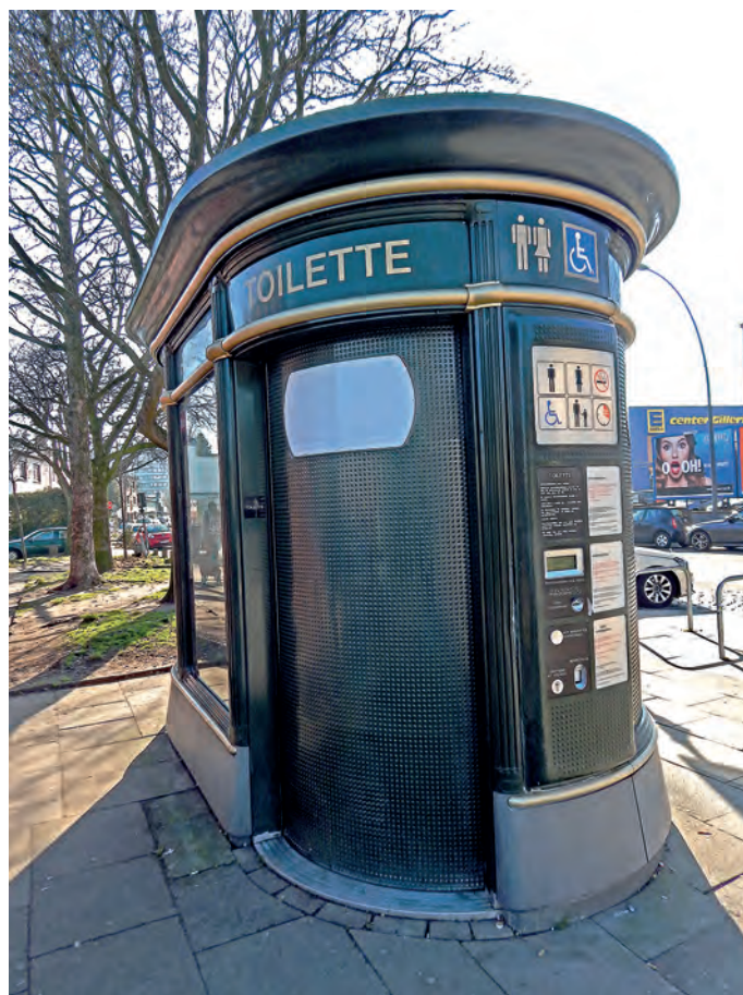
Das stille Örtchen am Bahnhof Wandsbeker Chaussee. Foto: Winfried Mangelsdorff
