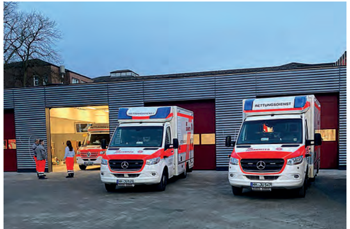
Die neue Rettungswache auf dem Gelände der Schön Klinik in Eilbek bietet Platz für vier Einsatzfahrzeuge. Foto: Carsten Moll / Johanniter
