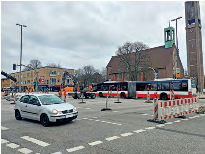
Nichts geht mehr: Die Kreuzung wurde großflächig aufgerissen. Fotos: Winfried Mangelsdorff
