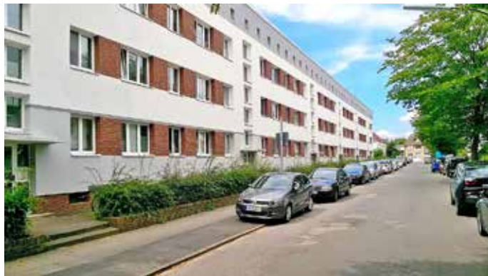
Auf den ersten Blick zu erkennen: Kein Platz in der Fehmarnstraße für Elektrotankstellen.
