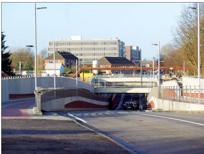
Die Unterführung in der Hammer Straße mit Blick Richtung Norden. Bis auf letzte Arbeiten im Außenbereich ist das Trogbauwerk fertiggestellt. Foto: Thorsten Richter
