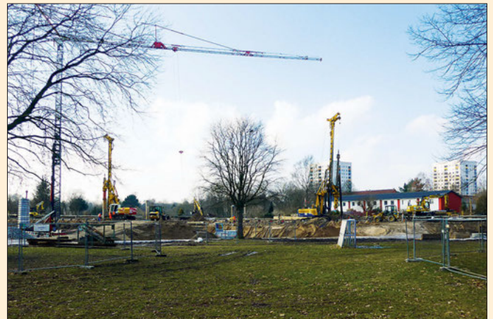
Blick aus der Straße Am Knill auf die Baustelle der Haltestelle U1 Oldenfelde. Foto: Thorsten Richter
