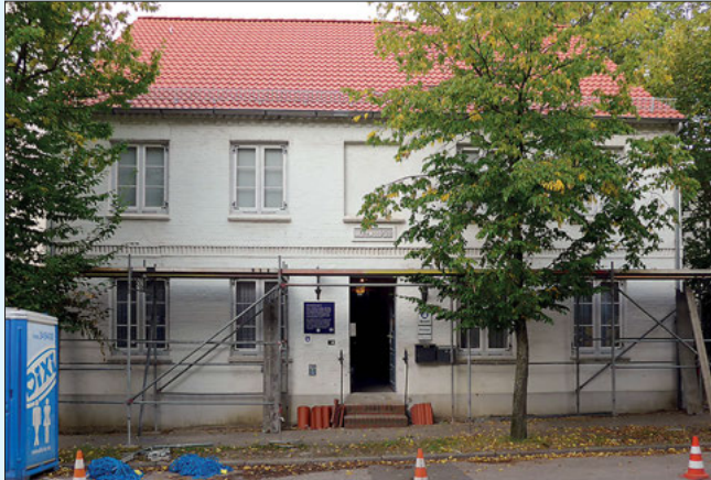
Das Gerüst, das für die Dacheindeckung notwendig war, ist fast abgebaut, unten am Eingang stehen noch überzählige Dachpfannen. Fotos, soweit nicht anders angegeben: Thorsten Richter
