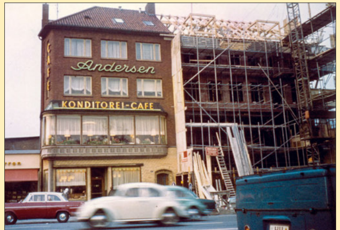
In der 60er Jahren wurde das Nebengebäude hochgezogen.
