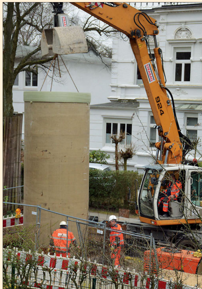
Auskleiden eines Revisionsschachtes.
