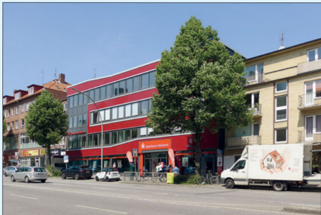
Die umfassend sanierte Filiale der Sparkasse Holstein in der Wandsbeker Marktstraße 163. Fotos: Thorsten Richter
