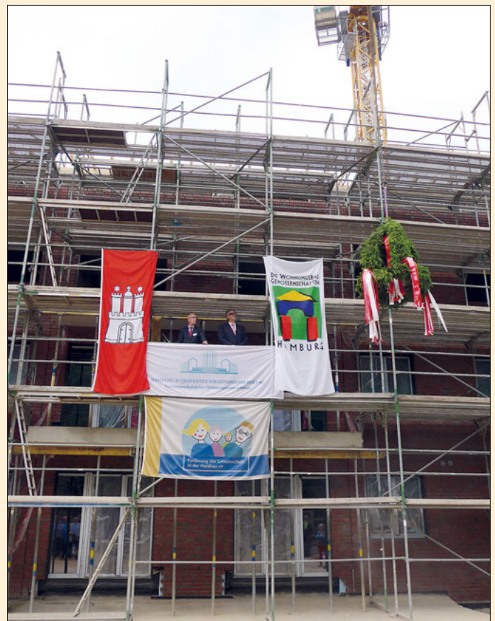
Hans-Jürgen Teudt (l.) verfolgte mit Bezirksamtsleiter Thomas Ritzenhoff das Hochziehen des Richtkranzes.
