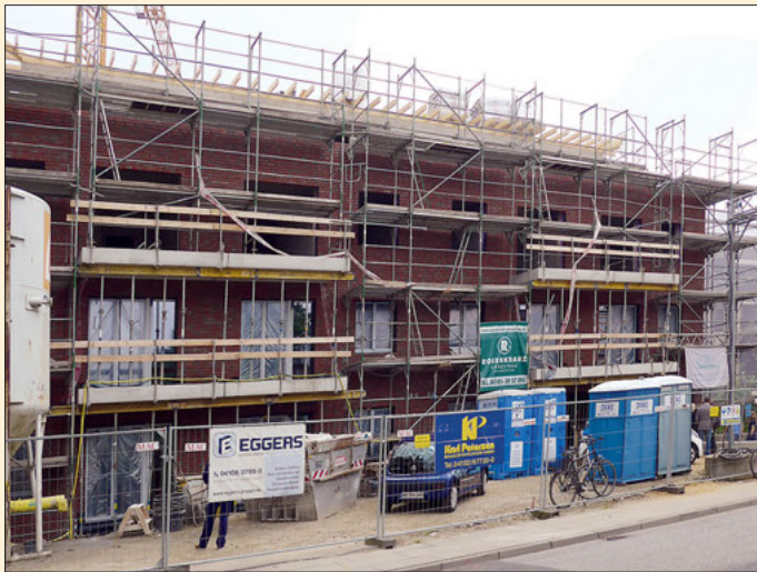
Die Gebäudefront an der Liliencronstraße 61. Fotos: Thorsten Richter
