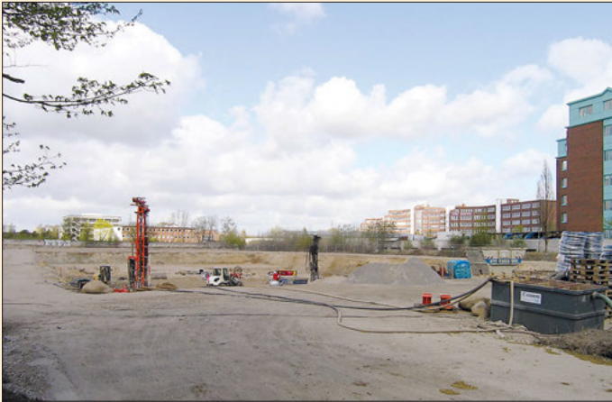
Die Baugrube für die neue Konzernzentrale der Jungheinrich AG im April 2014. Hinten sieht man bis zur Firma Rud. Otto Meyer (ROM) in der Tilsiter Straße, rechts die Bürohäuser in der Straße Am Stadtrand.
