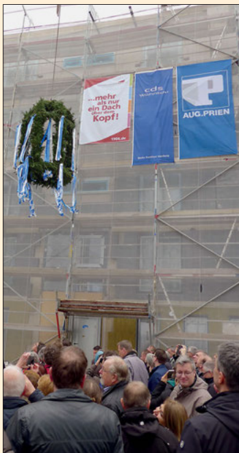
Der Richtkranz wurde von einem Baukran in die Höhe gezogen.
