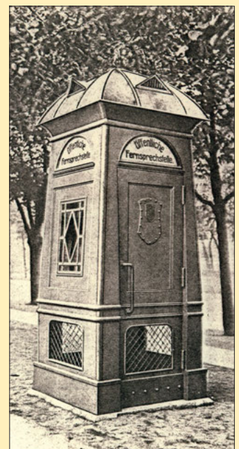
Zu den Lieferprodukten der Firma Petersen gehörten viele spezielle Entwicklungen für den Post- und Telegrafenaufbau, wie wettersichere Kabelverzweiger, Linienverzweiger, Kabelverschlüsse in verschiedenen Ausstattungen und auch die oben abgebildete Fernsprechkabine.
