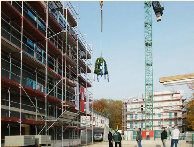
SAGA-Richtfest »Am Hohen Hause« für zwei Neubauten in Tonndorf.
