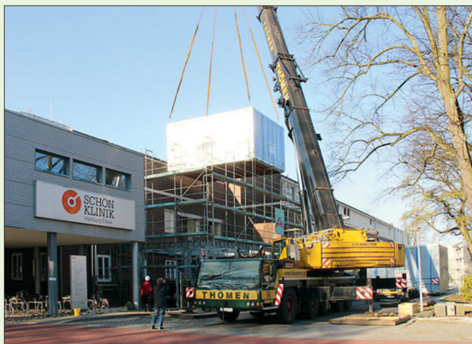
Zwei industriell vorgefertigte, moderne OPs in Raummodul-Bauweise wurden am letzten April-Wochenende angeliefert und aufgebaut.
