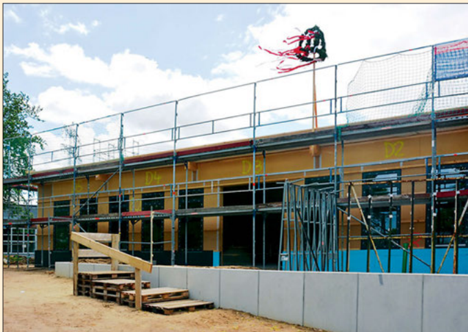
Durch den Anbau der Kantine hat sich das äußere Bild der Otto-Hahn-Schule, von der Jenfelder Allee aus gesehen, verändert. Weggefallen ist unter anderem der große prägnante Namenszug.
