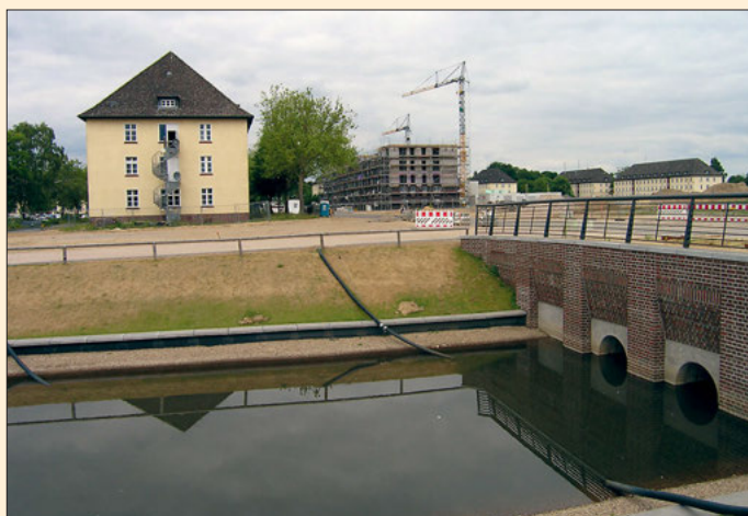
Das Brückenbauwerk über die Wasserkaskade. Hinten der Rohbau des »Inklusions-Wohnprojekts Jenfelder Au« der Bauherrengemeinschaft der Hamburger Blindenstiftung, des Lebenshilfe-Werks für Menschen mit geistiger Behinderung gGmbH und des Wohnungsvereins Hamburg von 1902 eG.
