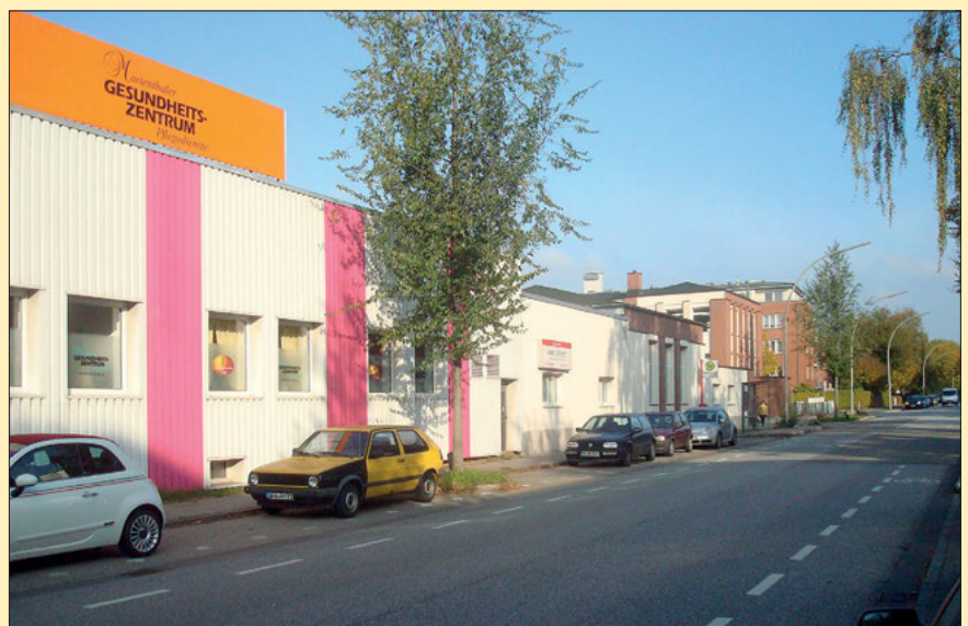
Der einstöckige Gebäudetrakt wurde bis vor ca. zwei Jahren von den Firmen Pizza Italia und Marienthaler Gesundheitszentrum genutzt und steht seitdem leer. Das Eckgebäude an der Kedenburgstraße ist Sitz der Polystar-Firma Rische + Herfurth.
