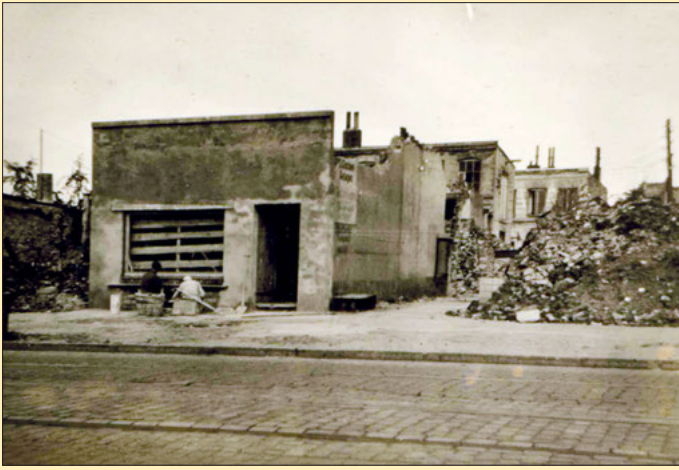
1948 wurde in Eigenleistung aus Trümmersteinen eine Baracke gebaut.
