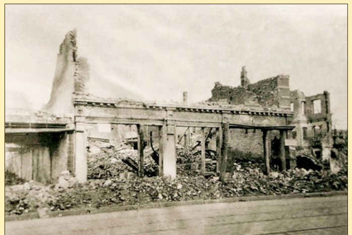
1943 wurde, wie so ziemlich die gesamte Wandsbeker Chaussee, auch das Gebäude Nr. 167–169 durch Bomben zerstört.
