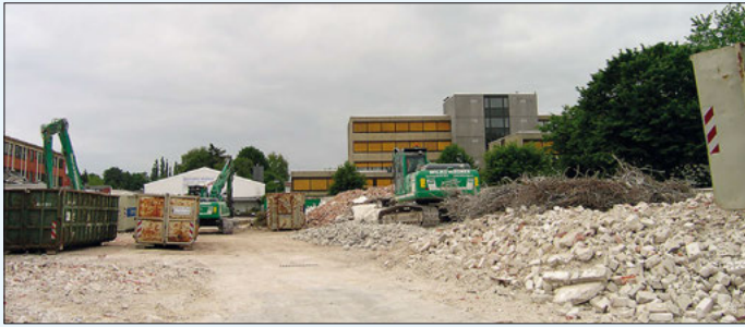
Auf diesem rund 8.000 m 2 großen Areal wird das »Mühlenquartier« der Becken-Gruppe entstehen. Fotos: Thorsten Richter
