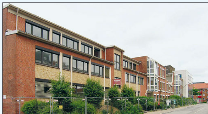
Die Häuserfront im Mühlenstieg kurz vor dem Abriss, Blickrichtung Osten. Am Ende das leer stehende Krauth-Gebäude.
