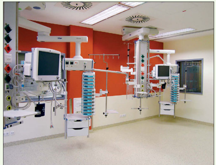
Ein Zweibettzimmer der neuen Intensivstation mit elektronischen Überwachungseinheiten. Die Betten (fehlten noch zur Einweihung) lassen sich zukünftig von speziellen, kranähnlichen Deckenliftern ansteuern, um Patienten noch vorsichtiger und zugleich für das medizinische Personal rückenschonender anzuheben oder umzulagern.
