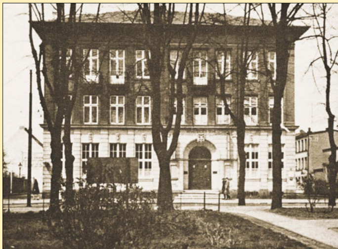
Das Bankgebäude der Volksbank in der Wandsbeker Marktstraße 99, 1891 bis zur Ausbombung 1943.
