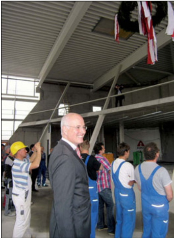
Dr. Alexander Tiedtke, Inhaber vom Autohaus Willy Tiedtke, beim Richtfest in der Halle des neu entstehenden Audi-Terminals. Foto: T. Richter
