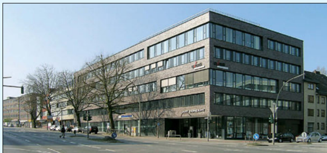
Das heutige Gebäude schließt nahtlos an die Bestandsgebäude in der Kattunbleiche und Wandsbeker Allee an. Foto: T. Richter
