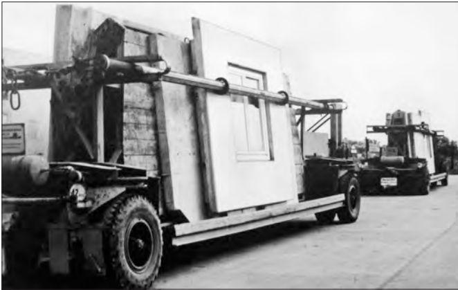
Oben: Die Plattenbauweise ermöglichte einen schnellen Baufortschritt. Die Hauselemente wurden mit Lkws angefahren. Rechts oben: Es wurden außer Mehrfamilienhäuser auch Einfamilienhäuser und Reihenhäuser errichtet.
