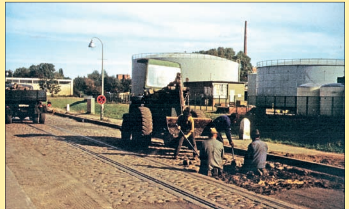
Nach Fertigstellung des neuen Flussbettes wurde die Hogrevestraße ausgebaut, die Gleise der Industriebahn und das Kopfsteinpflaster verschwanden.
