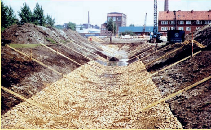
Sorgfältig wurde das neue Flussbett angelegt. Im Hintergrund ist der Brückenbau Wendemuthstraße sowie das Helbingwerk zu sehen.
