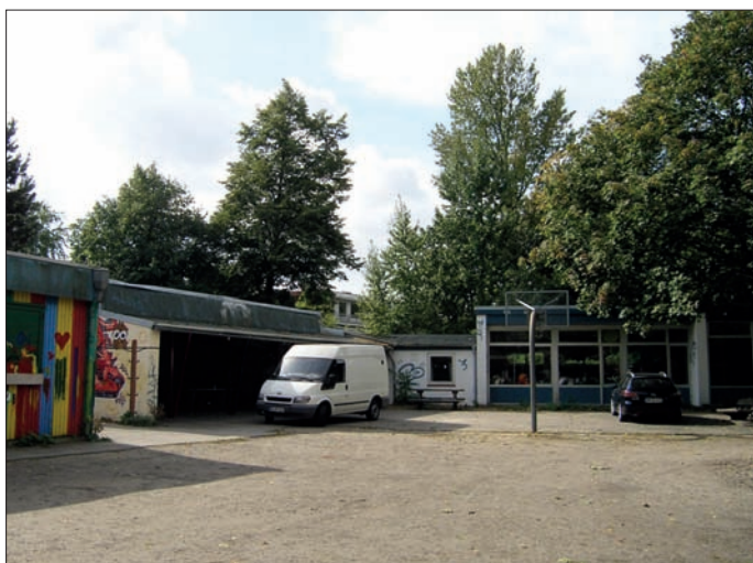
Die alten Gebäude des Spielhauses aus dem Jahre 1977, die der gegenüber liegende Neubau ersetzt.
