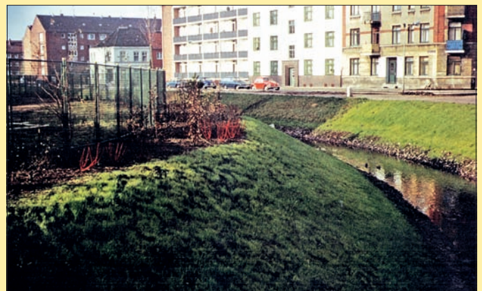
In einer großen S-Kurve fließt die Wandse in ihrem neuen Bett entlang der Hogrevestraße.
