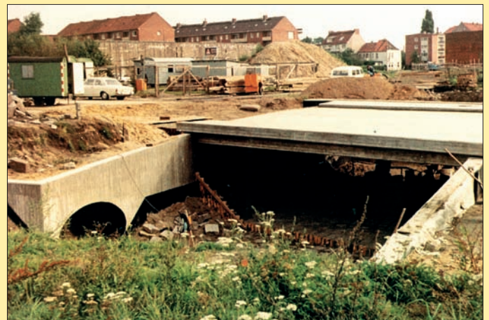
Die neue Brückenkonstruktion für den Verkehr in der Wendemuthstraße. Im Hintergrund sind die Wohnblocks an der Hogrevestraße zu sehen.
