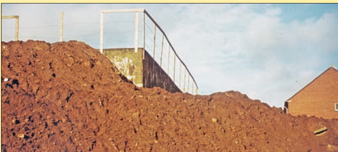
Der alte Luftschutzbunker wird mit Erdreich bedeckt. Heute ist er nur noch als grün bewachsener Hügel wahrnehmbar.
