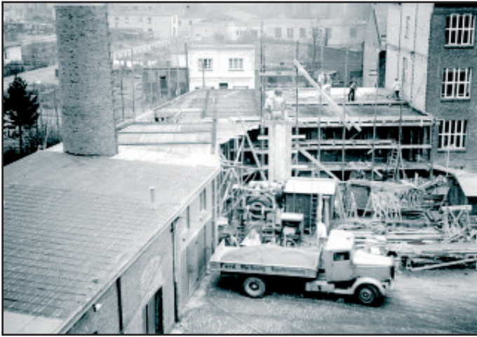
Das Wandsbeker Bauunternehmen Ferd. Helbing führte in den 1950er Jahren Erweiterungsmaßnahmen an einigen Gebäuden durch.
