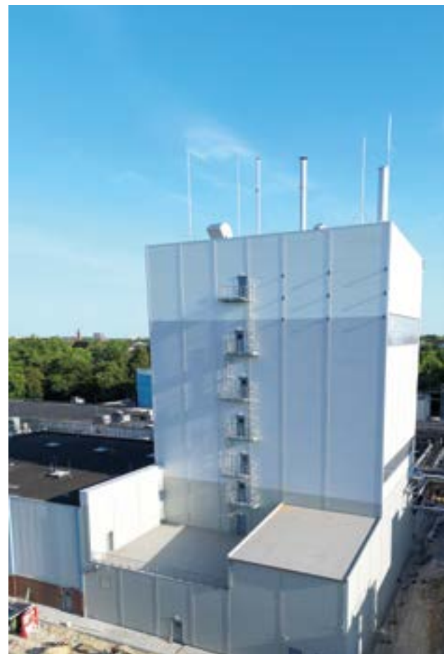
Der neue Sprühlturm von Ohly – eine Zukunftsinvestition für mehr Sicherheit und Dekarbonisierung. Foto: Ohly
