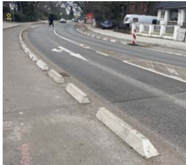
Trennelemente zwischen Fahrbahn und Radweg in der Berner Straße.
