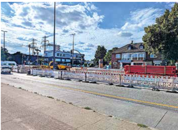
Großbaustelle an der Kreuzung Rodigallee/Holstenhofweg.
