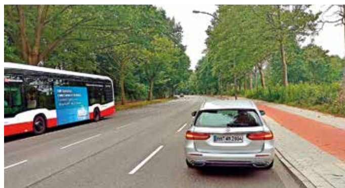
Viel Platz für Autos, Radfahrer und Fußgänger – und trotzdem soll der Berner Heerweg umgebaut werden.
