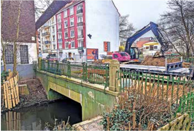
Die Brücke in der Kedenburgstraße wird erneuert. Foto Winfried Mangelsdorff
