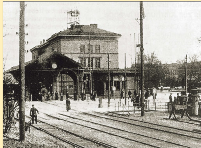
Der erste Lübecker Bahnhof mit dem südlichen Bahnübergang über die Thorstraße.
